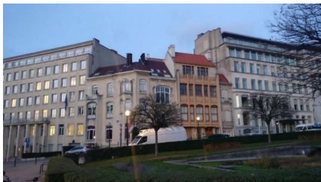
Façades de l'hôtel Van Eetvelde, réalisé en plusieurs phases © Urban.brussels
