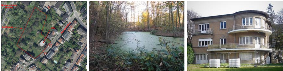
Vue aérienne (source Urbis) annotée du périmètre concerné par la demande, vues actuelles de l'étang (extr. du dossier de demande) et de la façade arrière de la villa (© Urban)
