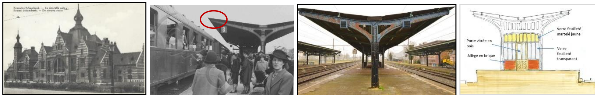
Vue de la gare de Schaerbeek, état des auvents en 1942 et aujourd'hui (portiques rognés suite à l'électrification des lignes) et proposition de reconstitution des salles d'attente, images extraites de la demande d'avis de principe
