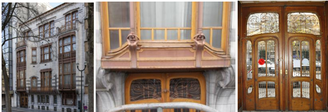
Photo de la façade et des menuiseries extérieures de l'hôtel. Photos extraites du dossier de demande
