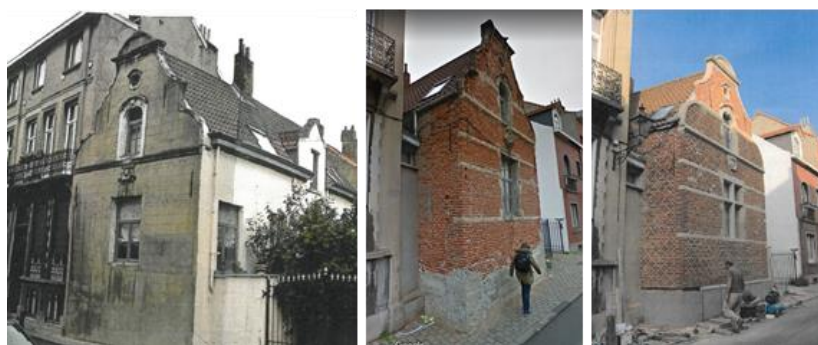
V.l.n.r.: Toestand vóór het afbikken ©KCML, toestand na afkapping © Google Street View en toestand na restauratie van de bakstenen in 2017 ©urban.brussels.
