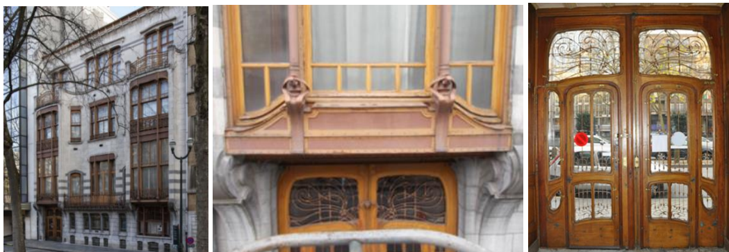
Foto van de gevel en het buitenschrijnwerk van het huis. Foto's uit het aanvraagdossier
