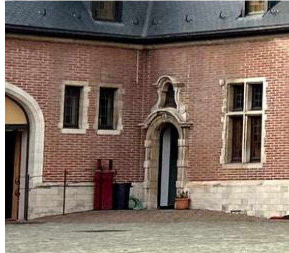
Rampe douce et garde-corps sur mesure intégrés dans la cour du château du Karreveld, à Molenbeek-Saint-Jean (© CRMS).
