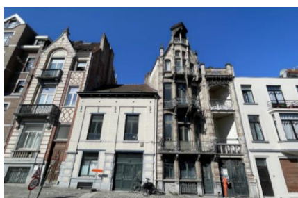
Façades avant des n°s 83 et 85-87 (photographie extraite du dossier)
