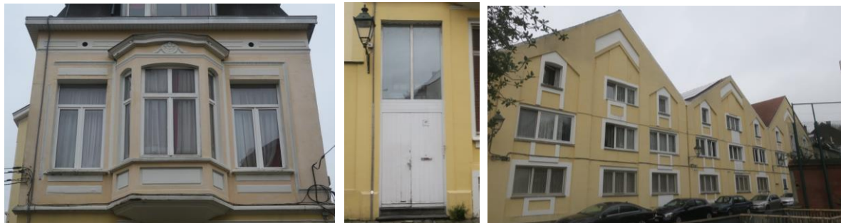
Façade côté Palais Outre-Ponts avec sa logette et sa porte d'entrée, visible depuis l'édifice classé. A droite, les façades de la rue du Timon (photos CRMS, décembre 2024)
