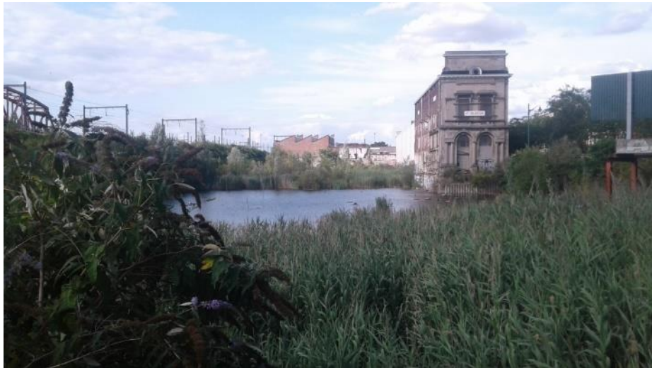
Vue actuelle du marais Wiels vers le bâtiment Métropole (© photo CRMS, octobre 2024)
