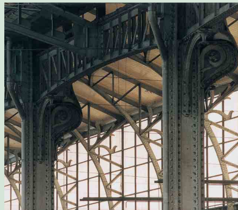
Gare maritime de Tour et Taxis, rue E. Picard à Molenbeek-Saint-Jean, E. Van Humbeek, 1904-1907. © Photo M.-F. Plissart.
