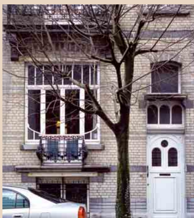
Rue Wafelaerts n° 61 et 66 à Saint-Gilles. Châssis du bel étage de deux maisons de maître identiques, l'un d'origine (n° 61, à droite), l'autre remplacé récemment par un châssis en bois de méranti (n° 66). © Photos Ph. De Gobert.
