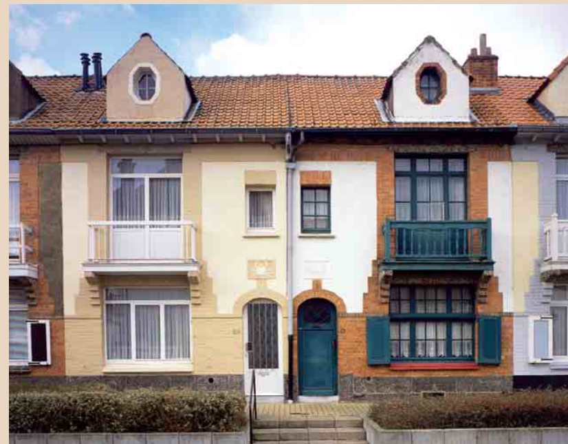
Cité-jardin Diongre à Molenbeek Saint-Jean, J. Diongre, 1925. A gauche les menuiseries extérieures ont été remplacées par des modèles en PVC, à droite les menuiseries d'origine ont été conservées. © CRMS - Photo Ph. De Gobert.
