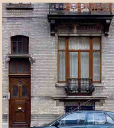
Rue Wafelaerts n° 61 et 66 à Saint-Gilles. Châssis du bel étage de deux maisons de maître identiques, l'un d'origine (n° 61, à droite), l'autre remplacé récemment par un châssis en bois de méranti (n° 66). © Photos Ph. De Gobert.
