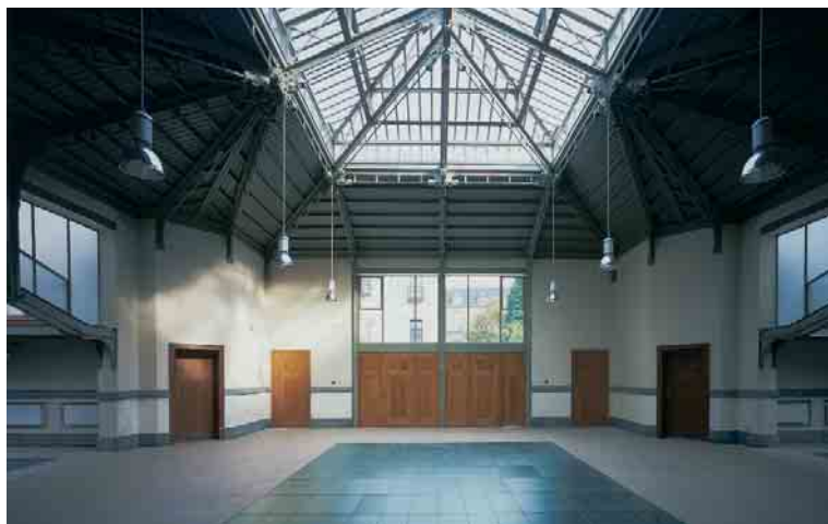
Jardin d'enfants, rue Saint-Ghislain à Bruxelles, V. Horta, 1895-1898. Classé en 1976. Restauration B. Van der Wee, 2001. Des interventions contemporaines ont permis d'actualiser le complexe scolaire d'origine et d'en poursuivre les activités. © CRMS - Photo Ch. Bastin et J. Evrard.
