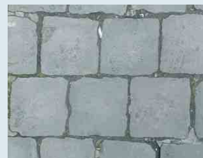
Kasseien – traditionele plaatsing met nauwe voegen / hedendaagse plaatsing met cementvoegen. © Foto's KCML.
