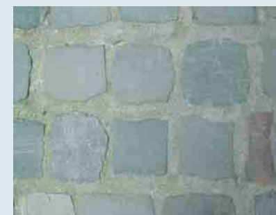
Kasseien – traditionele plaatsing met nauwe voegen / hedendaagse plaatsing met cementvoegen. © Foto's KCML.
