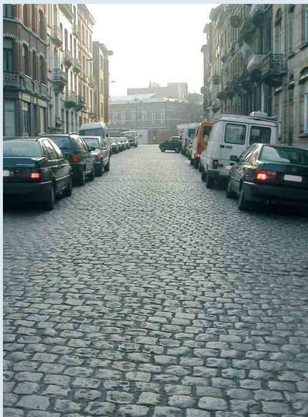
Karperstraat te Sint-Jans-Molenbeek. Voorbeeld van een straat die omstreeks een eeuw geleden volgens de traditionele technieken werd geplaveid. © Foto KCML.
