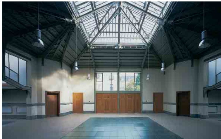
Kindertuin, Sint-Gisleinsstraat te Brussel, V. Horta, 1895-98. Beschermd in 1976. Restauratie B. Van der Wee, 2001. Hedendaagse ingrepen maakten het mogelijk het beschermde schoolcomplex aan het huidige gebruik aan te passen en zo de oorspronkelijke bestemming te behouden. © KCML - Foto Ch. Bastin et J. Evrard.
