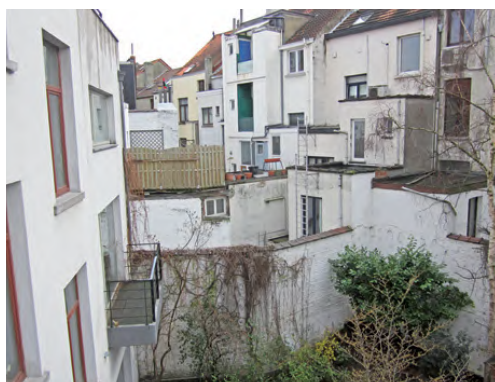
Rue du Béguinage – Bruxelles
