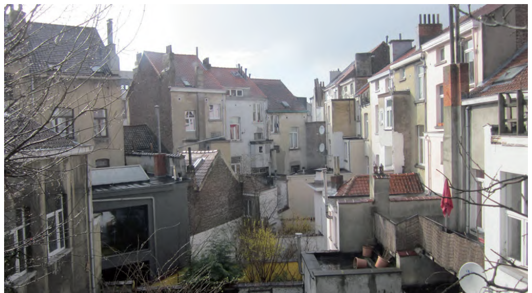
Cœur d'îlot montrant le développement des annexes. L'isolation extérieure peut être appliquée sans précaution particulière.
