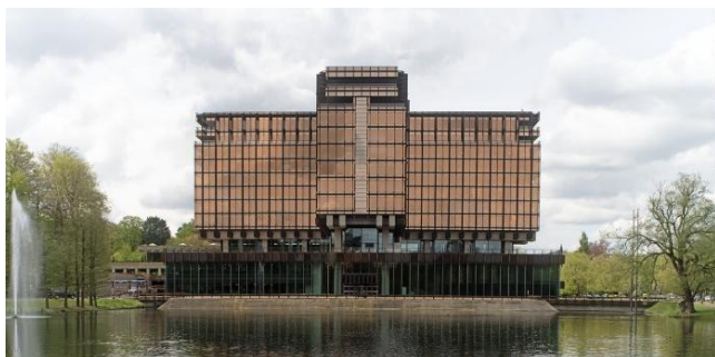
Vue du bâtiment principal depuis le parc (© urban.brussels)
