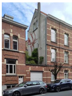
Vues du bien depuis la rue de la Réforme (extrait du dossier de demande)
