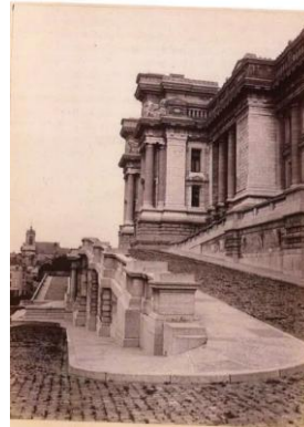
Vues anciennes des rampes. Source : T. HENRARD et Th. GRECK, 'Les rampes et terrasses du Palais de Justice de Bruxelles – Étude préalable, juin 2023
