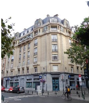
Vue de l'immeuble (© Inventaire)
