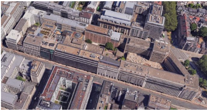
Vue aérienne de l'îlot concerné. ©Google Street View
