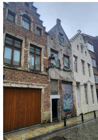
Photo de la façade existante. Extraits de la demande
