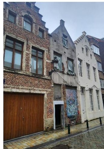
Foto van de bestaande gevel, uit de aanvraag
