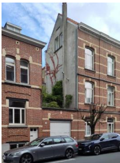
Zicht op het goed vanaf de Hervormingsstraat (uit het aanvraagdossier)
