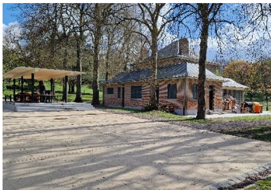
Photo de l'arrière du chalet. Photo CRMS 2026
