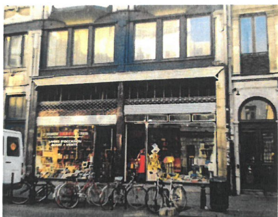
Photo prise lors de travaux sur le store - extraite du dossier
