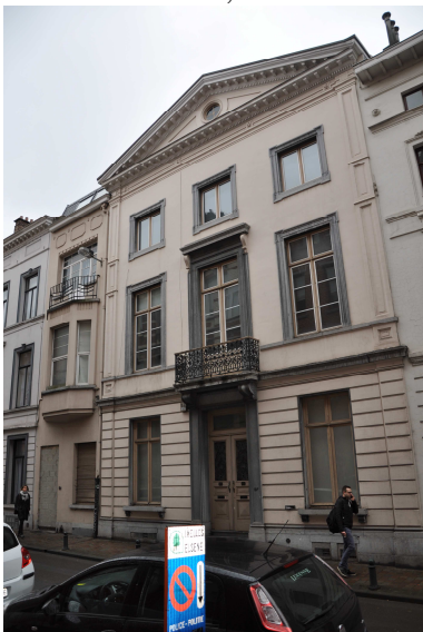
Façades à rue des n°s 89-87
