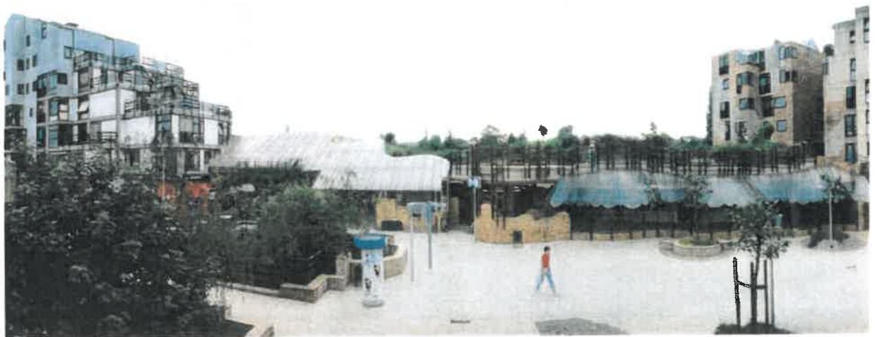
La façade ouest de la station de métro Alma. Au niveau supérieur : la Promenade plantée de l'Alma. A gauche, le Mairie et, à droite le Centre oecuménique. Photo Bastin&Evrard, 1982.
