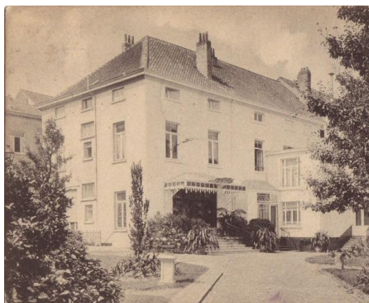
Façades latérale et arrière avant 1920 (cachet de la poste de 1920 ; collection de Dexia Banque)
