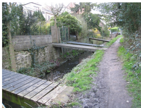
Situation préexistante – photo Brugis
