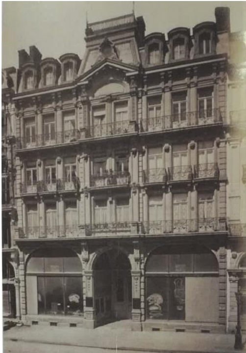
Aspect d'origine de la façade (1876)
