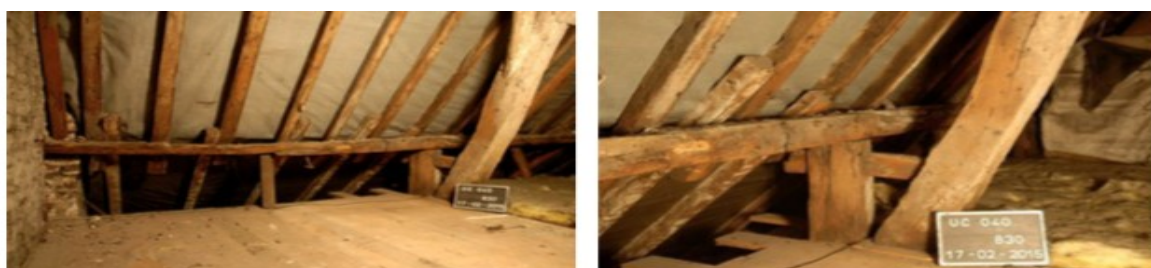
L'espace des combles : la facade arrière. UC040_0209, UC040_0210. Photos, S. Modrie © SPRB
