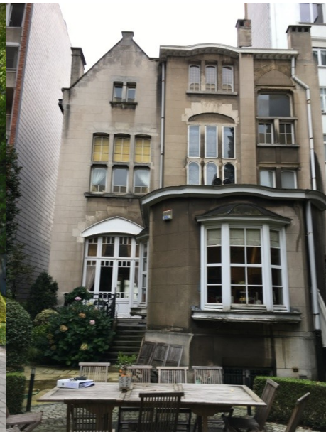
Fig. 2. Façade arrière de la villa "Les Iris". Cliché d'octobre 2017. © DMS.
