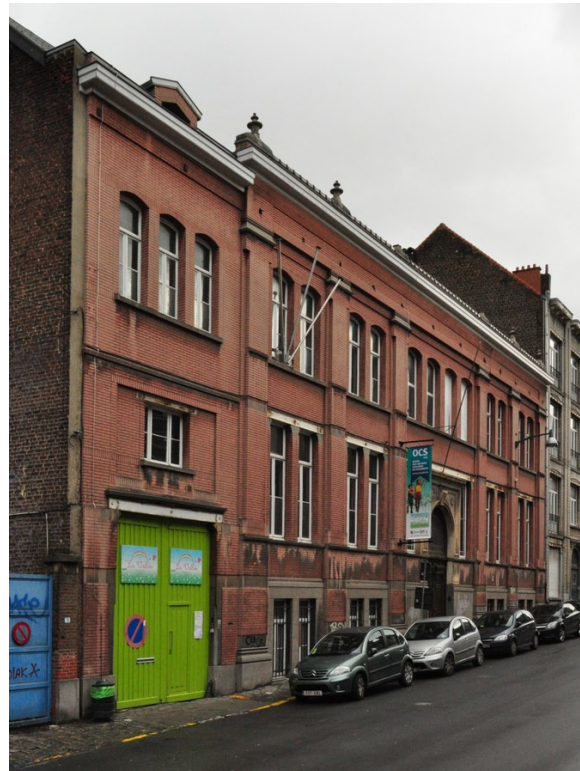
Fig. 4. Vue de la façade Grande rue au Bois en 2012. © BUP - DMS
