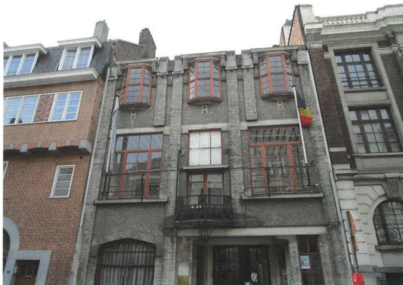
Vue générale en 2017 (extr. de la demande de permis unique, 2018)
