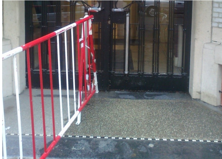
Sol de l'entrée, situation existante. © DMS, 2013
