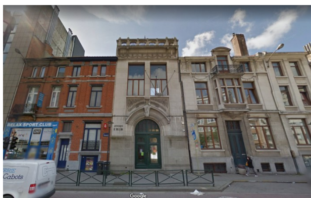
Fig. 3. Pavillon d'entrée au n° 61 avenue de Roodebeek. © Google Street View, juin 2017.
