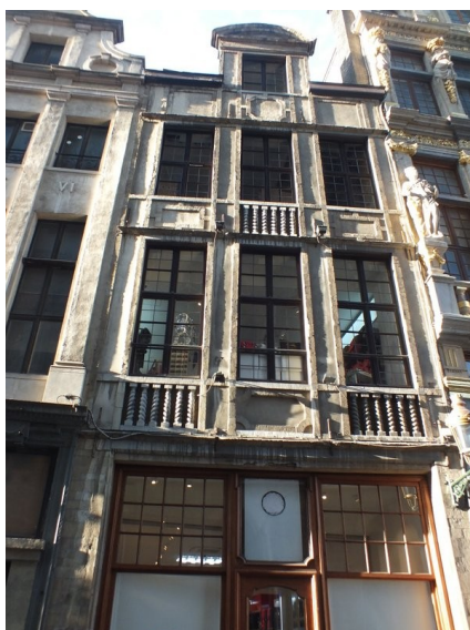
Fig. 1. Vue de la façade avant du n° 1 rue de la Tête d'Or. © CRMS, octobre 2018.
