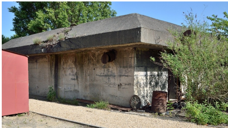
Fig. 2. Ancien abri hôpital. Cliché DMS, mai 2018.
