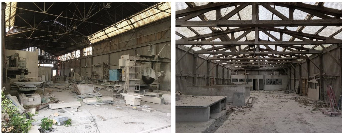
Vues intérieures des hangars métalliques et en bois (en haut à droite) – © Aries et © BUP
