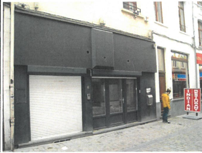
Rue de la Fourche, n° 9 (©CRMS), 2019
