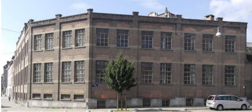
Angle des rues de l'Aiguille et Scheutveld - Photo BUP
