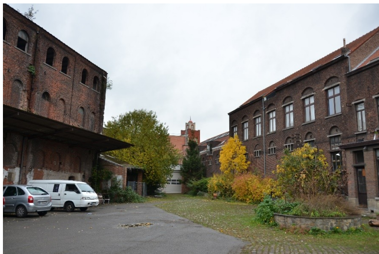
Cour intérieure, état 2019 - Photo CRMS
