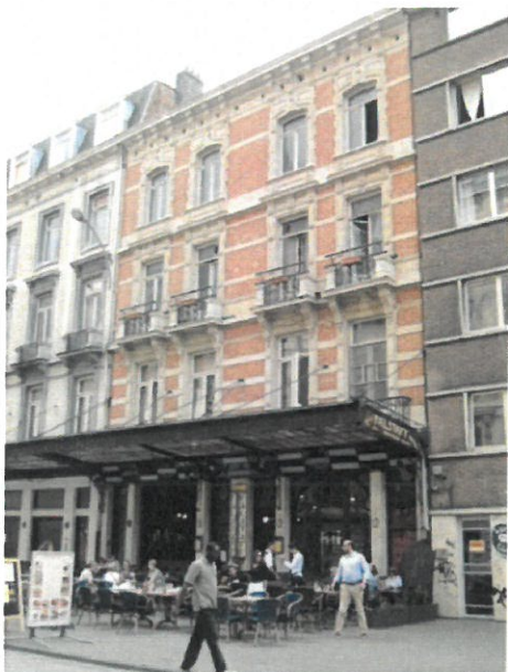
Façade avant © BUP
