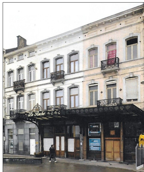
Fig. 1. Boulevard Jamar, 1a à 1c, façades à rue. Cliché ARCHistory, mars 2019.
