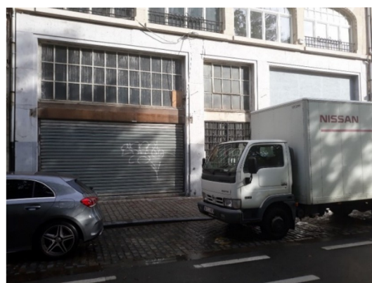
Vue d'ensemble et détails du rez-de-chaussée et de l'entresol (©CRMS - 2019)
