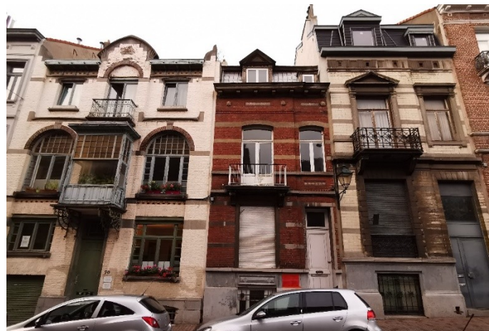
Fig. 1. Vue de la façade avant du n° 72 rue d'Irlande (au centre).
