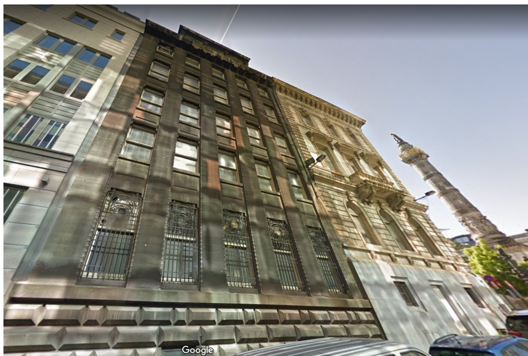
Fig. 2. Vue des façades rue Vandermeulen. © Google Maps, 2017.
