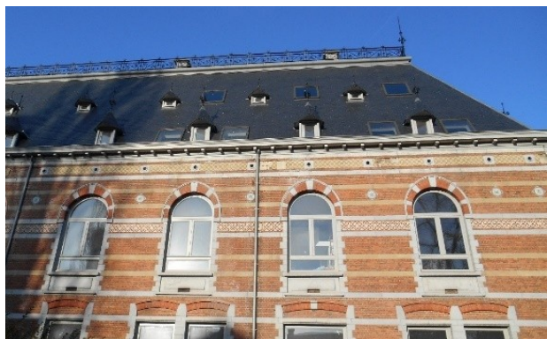
Links dakvlakramen in de vleugel vooraan links van de 'Grote Kliniek', toestand 10/01/2014 (SV 01/PFU/236086) en rechts dakvlakramen rechter vleugel vooraan links van de 'Grote Kliniek', toestand 16/10/2015 (SV 01/PFU/463612).
