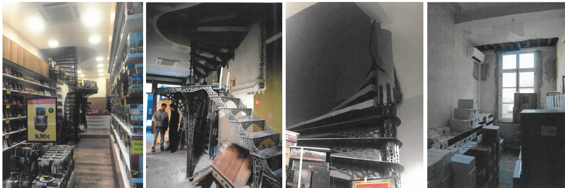
Escalier présent dans l'espace commercial et conditionnement installé au premier étage – images jointes à la demande
