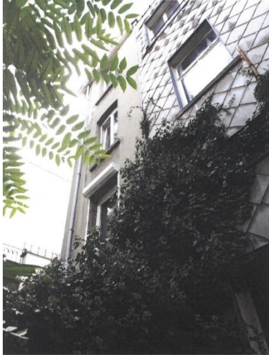
(La façade arrière de l'immeuble avec son revêtement d'ardoise actuel et la façade arrière de l'immeuble voisin sis n°12 - Image tirée du dossier)
