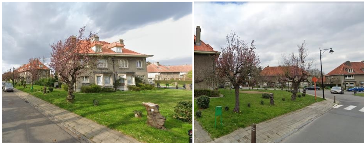
Vue de la situation sanitaire actuelle. A gauche : Avenue des Nymphes. A droite : Angle du Berensheide et de l'avenue des Sylphes. Source : Google Street View.
