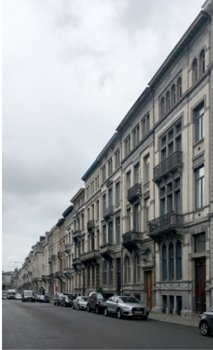
vue depuis la rue aux Laines situation existante
