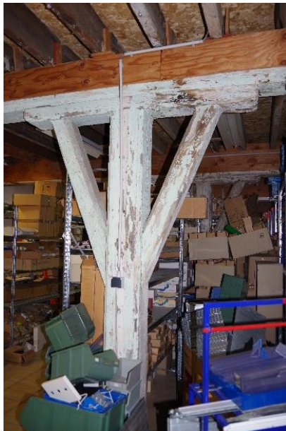
A gauche : Photo de l'intérieur du bâtiment avec ses structures en poteaux-poutres de bois. Photo CRMS
