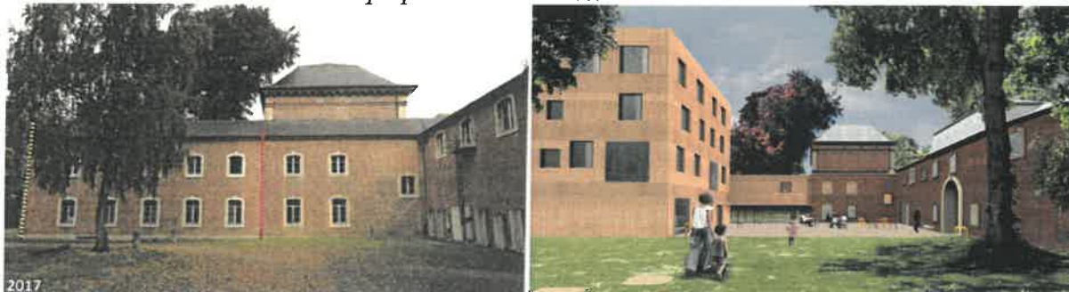
Extraits du dossier -. Démolition de l'extension signée par les frères Mignot, dans un style se voulant dans la prolongation de l'aile perpendiculaire Ouest - Il est prévu de démolir toute l'extension tardive, mais de maintenir l'ancien volume de connexion. Ce volume est d'origine (projet néo-classique Dewez)
