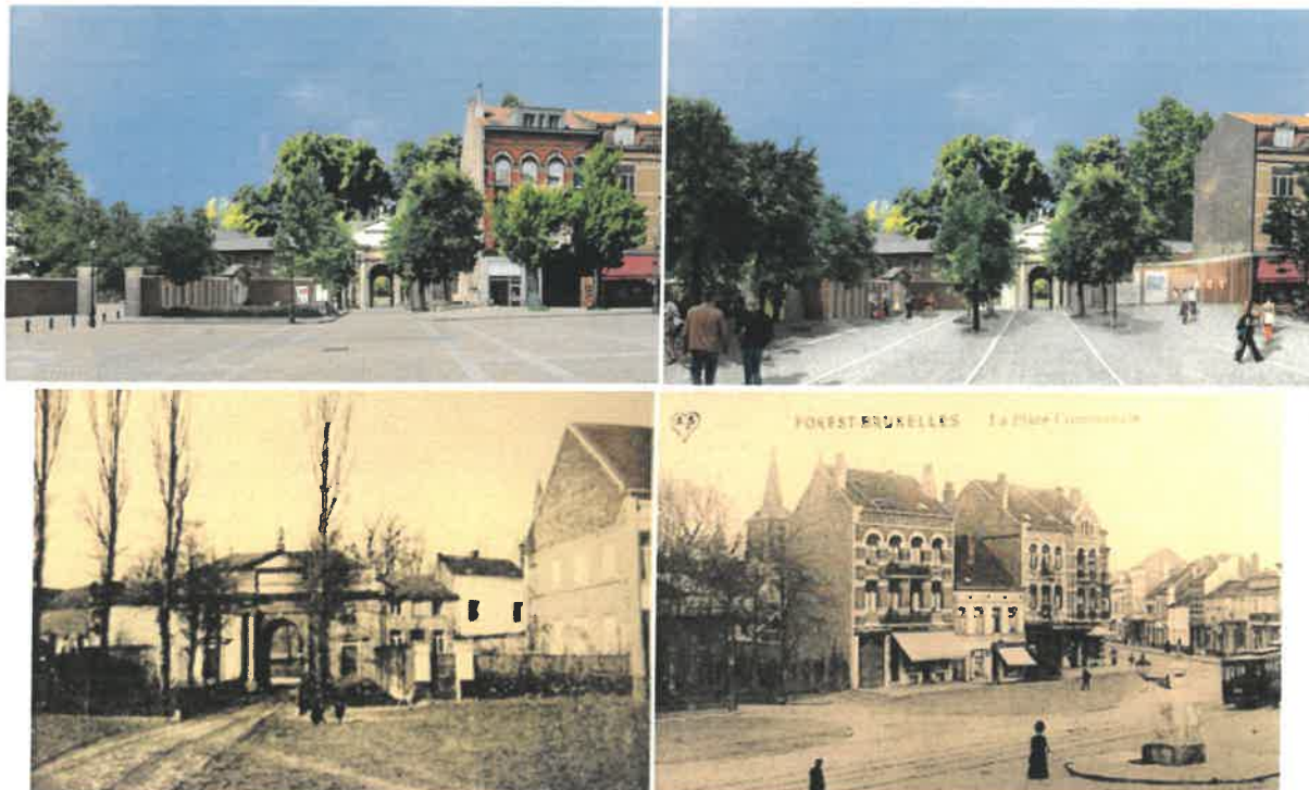
Extraits du dossier -. Le pignon en attente suite à la démolition de la maison sise 6 place Saint-Denis sera isolé et habillé d'un aluminium microperforé, de teinte anodisée bronze
