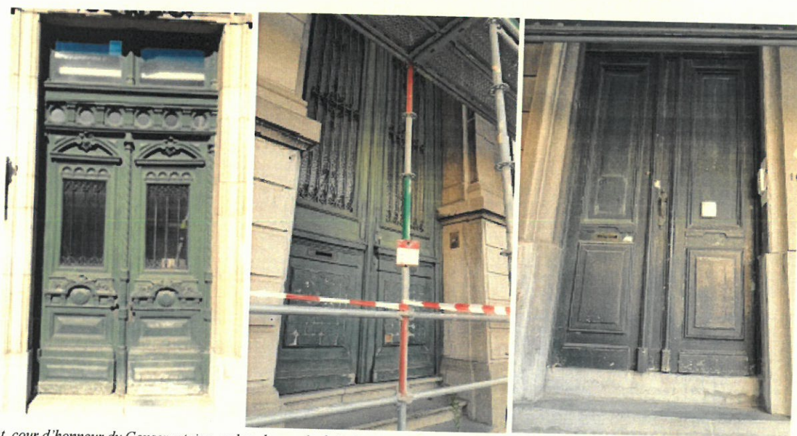
En haut, cour d'honneur du Conservatoire, en bas de gauche à droite : porte du Conservatoire, de la maison du directeur et de la maison 16, place du Petit Sablon – images jointes à la demande
