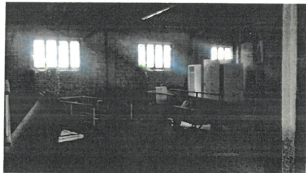
Photo 5 - Hangar comportant une structure portante composée de colonnes en béton ainsi que la charpente en bois.
