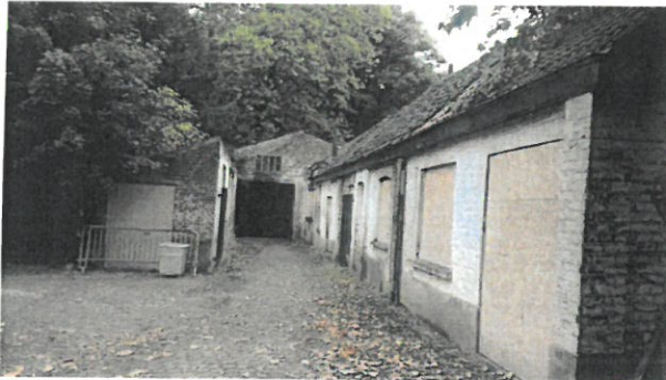
Photo 2 - Vue générale des locaux, ainsi que la zone d'accès entrées. Dans le fond, la bois permettrait l'accès à la zone de stockage.
