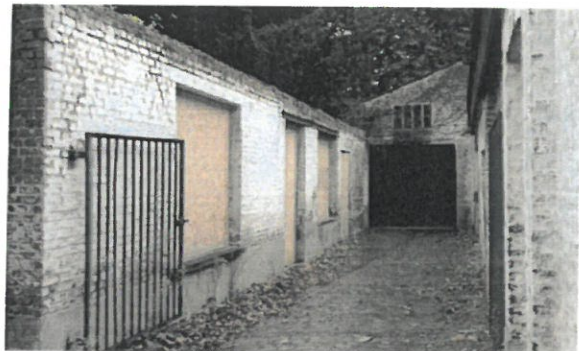
Photo 3 - Vue latérale gauche depuis l'entrée des locaux.
