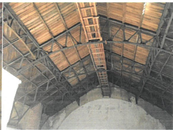
Photo 6 - Charpente métallique supportant la toiture.
