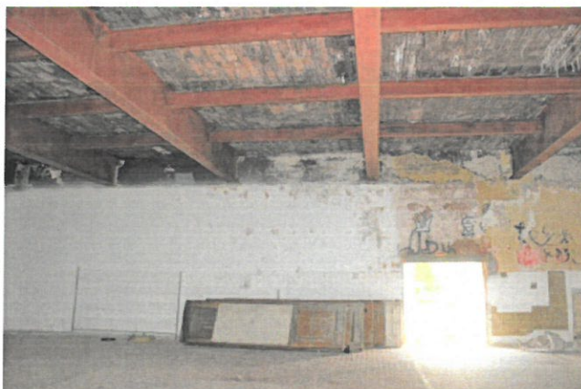
Photo 5 - Travaux de scellement de la dalle existante.
