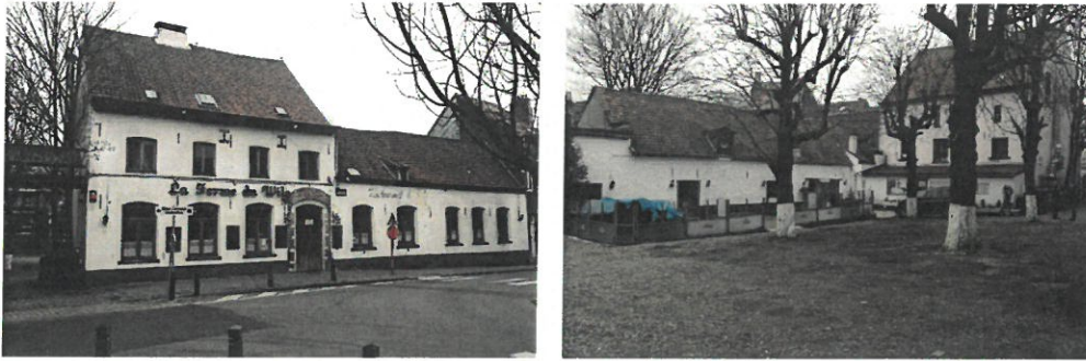
La ferme du Wilg, façade à rue et arrière, état existant © Urban.brussels
