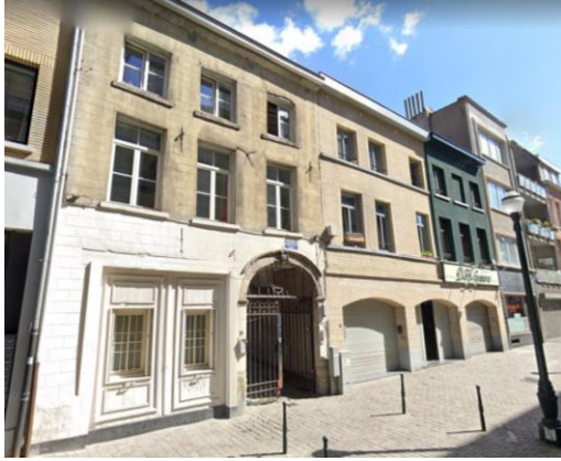
Vue sur l'entrée de l'Impasse Quai au foin 15. ©Google Street View
