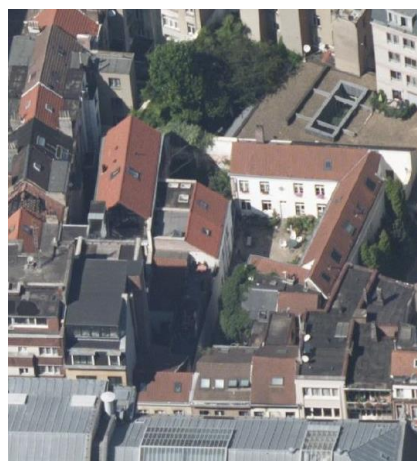
Vue aérienne de l'impasse. ©Bing Maps
