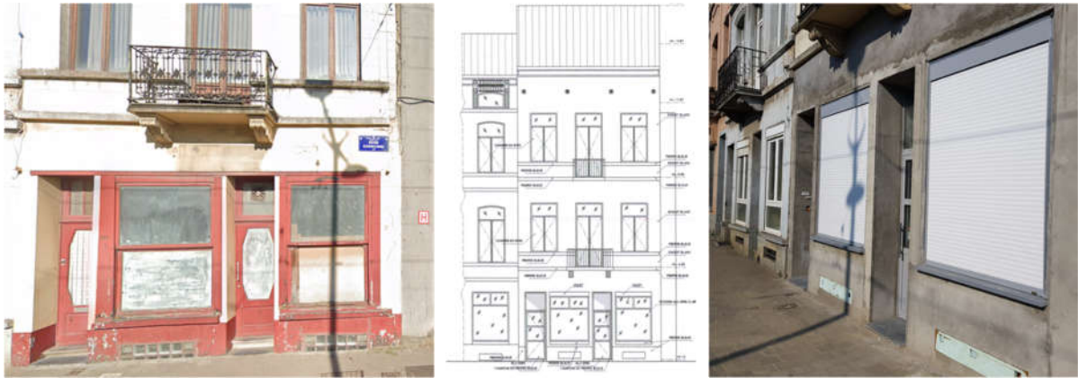
Vues de la devanture avant travaux (©Google maps, 2019), de l'élévation projetée (extr. du dossier de demande) et vue actuelle (©CRMS)
