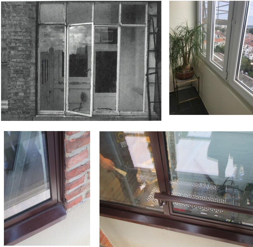
Châssis des années 1930, fermeture existante du balcon 2.13.A et châssis mis récemment en œuvre dans l'appartement 2.11.D – photos jointes à la demande et © Urban.brussels
