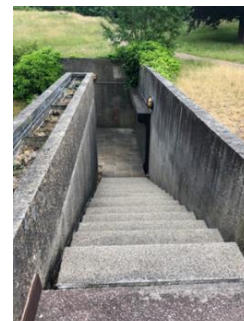
Escalier existant sur le site – photo extraite du dossier de demande
