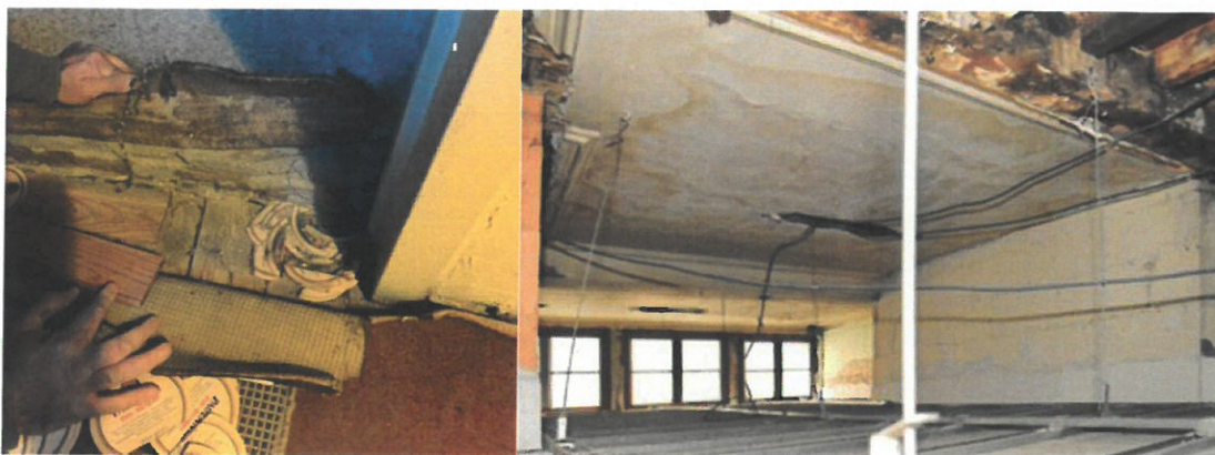
A gauche, état existant du plancher de l'étage +1, photo jointe à la demande / À droite, plafond néoclassique masqué par le faux-plafond actuel, photo extraite de l'État de référence
