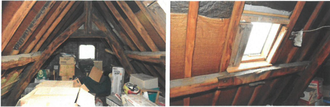
Etat de la charpente, photo extraite de l'État de référence
