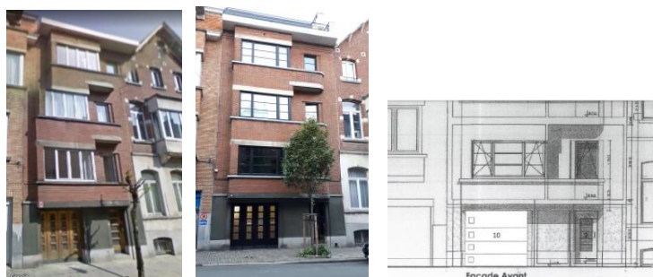
Façade avant et après le remplacement des châssis aux étages mais avec la porte de garage d'origine. A droite, projet de nouvelle porte de garage (extraits du dossier)
